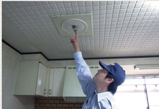
火災警報器などの設置状況調べる職員
